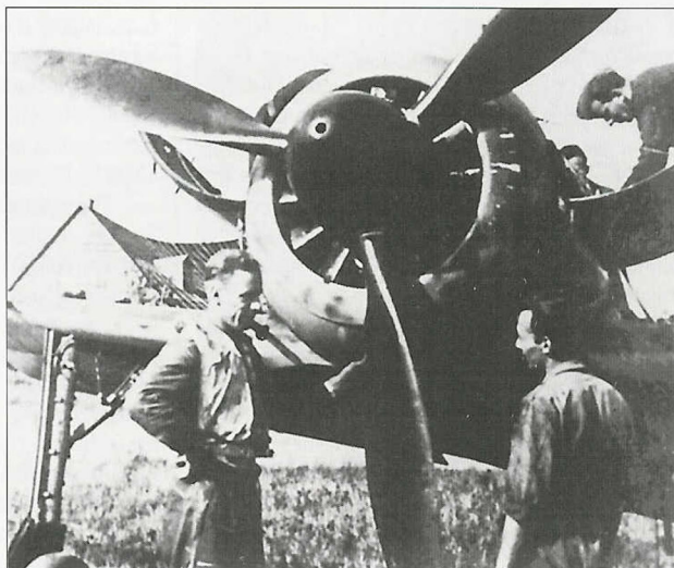
Przegląd silnika BMW 801 na lotnisku JG 26. Wiosna 1942 roku. Servicing BMW 801 engine at JG 26's airfield. Spring 1942.
